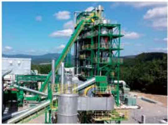
大分県のバイオマス発電所
