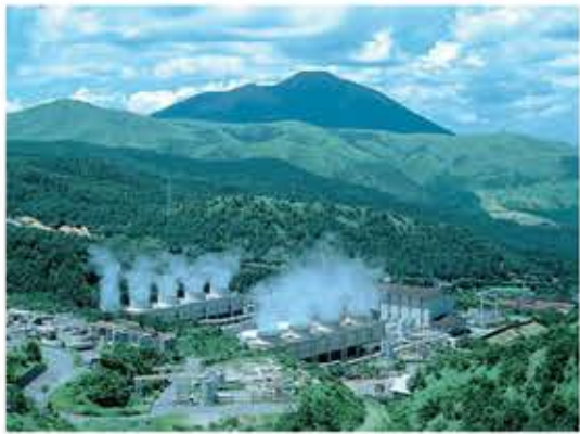
八丁原地熱発電所 (大分県)
