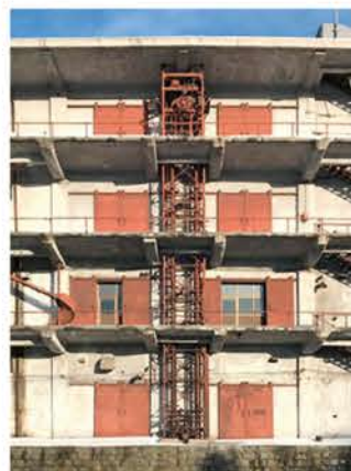
エレベーター
