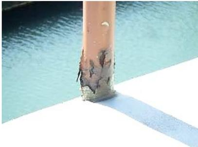
写真 2-28 手すりの腐食
