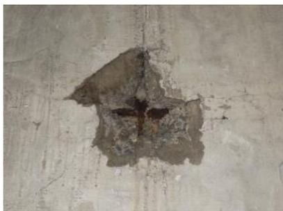
写真 2-19 断面欠損①
