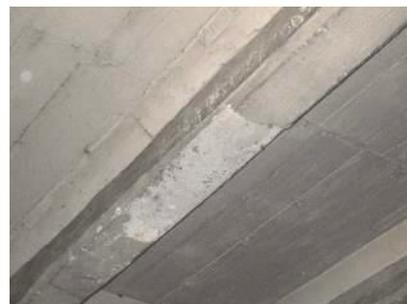
写真 2-20 断面欠損②
