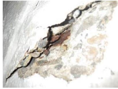
写真 2-22 鉄筋露出②
