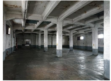
広い収納空間が確保されている第３倉庫内部
